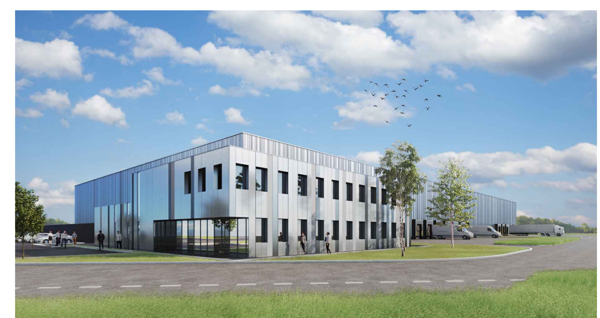
Plateforme Logistique 19 RUE DE MONTARAN 45 400 Fleury-les-Aubrais
